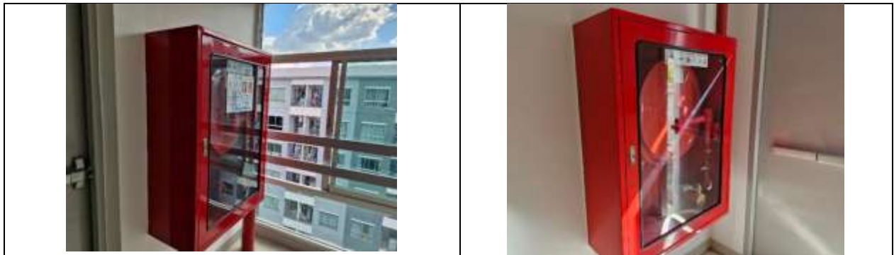
ระบบท่อเย็นและตู้เก็บสายฉีดน้ำดับเพลิง
